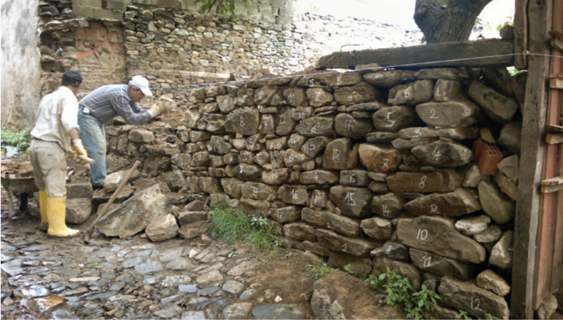
Resim 8. Taş duvarın yeniden örülmesi
