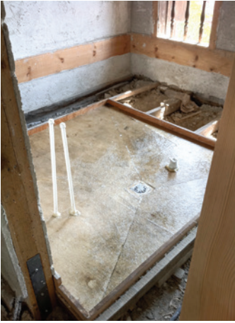
Resim 16. Islak hacimlerin altında, su kontrolü üzerine cam yünü takviyeli polyster uygulamalı tekneler (Ada kuvet montaj hazırlığı yapılmıştır; banyonun bitmiş hali Resim 25'te görülmektedir. Sol yandaki sökülebilir pano kirişlere kenetlenmiştir.)
