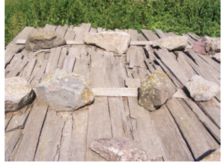
Resim 18. Geleneksel çatı kaplamasından görünüm
