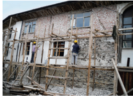
Resim 21. Kuzey cephede sıva raspası
