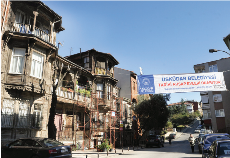
Resim 3. İcadiye Mahallesi, Cemil Meriç Sokak, bakım-onarım öncesi
