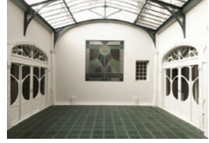
Resim 15. Kış bahçesi (onarım sonrası)
