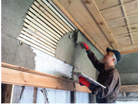
Resim 18. Çamur sıva uygulaması (Çamurun içinde belli oranda saman bulunmaktadır; daha sonra üzerine kırıklı perdah yapılacaktır.)
