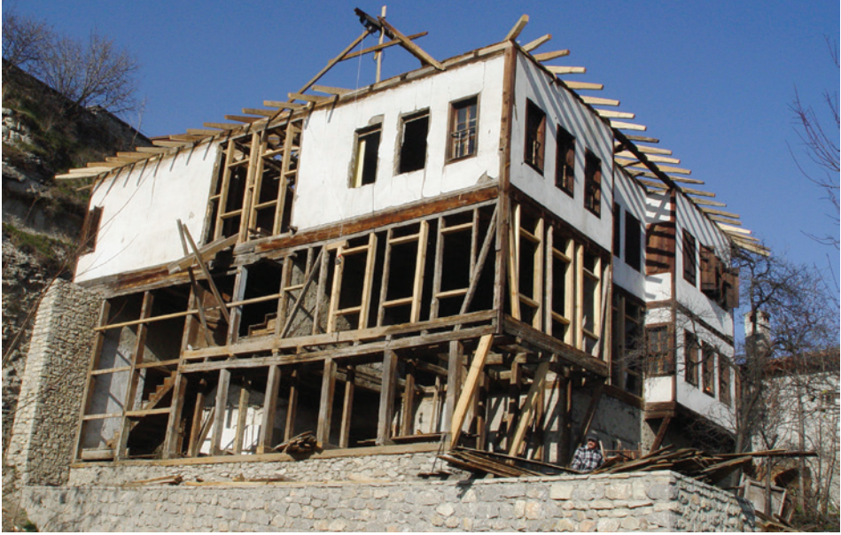
Resim 9. Ahşap iskeletin onarımı (Taş ve betonarme destekler temizlenmiş; istinat duvarı yapılarak zemin güçlendirilmiştir.)
