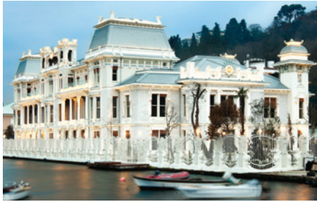
Resim 3. Mısır Başkonsolosluk Binası'nın bugünkü görünümü
