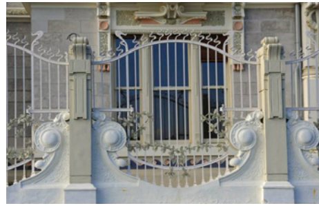
Resim 17. Ön döküm cephe elemanları (onarım sonrası)
