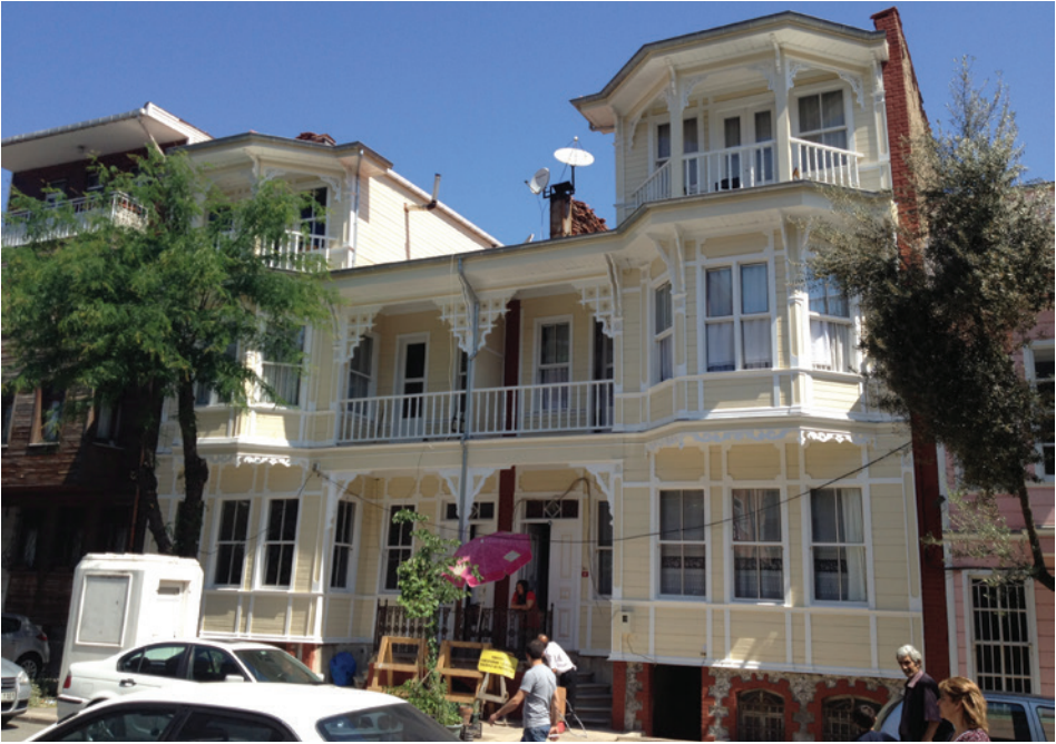
Resim 5. İcadiye Mahallesi, Cemil Meriç Sokak, bakım-onarım çalışması öncesi-sonrası
