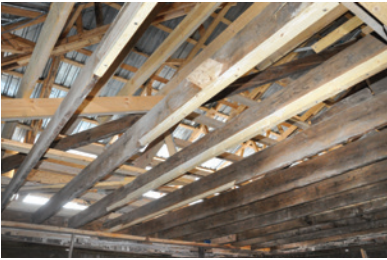
Resim 4. Yapı öğelerinin güçlendirme ve konservasyon uygulamaları
