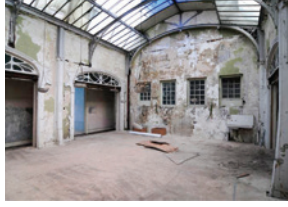
Resim 14. Kış bahçesi (onarım öncesi)
