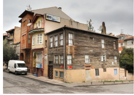
Resim 2. İcadiye Mahallesi, Cemil Meriç Sokak, bakım-onarım öncesi
