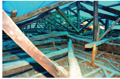
Resim 22. Caminin çatı konstrüksiyonu
