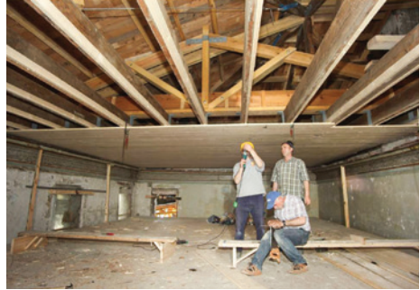
Resim 11. Kirişlerin askı ve konservasyon sonrası durumu
