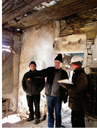
Resim 10. (a) 1/1000 ölçekli kent planı üzerinde Zeyrek'te işaretlenen 3 bölge, (b) I. Bölgede hasar tespit çalışmaları
