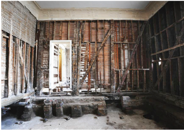
Resim 8. Ahşap konstrüksiyonun onarımı (Taşıyıcı sistem, meşe ana dikmeler ve çam ara dikmelerden oluşmaktadır.)
