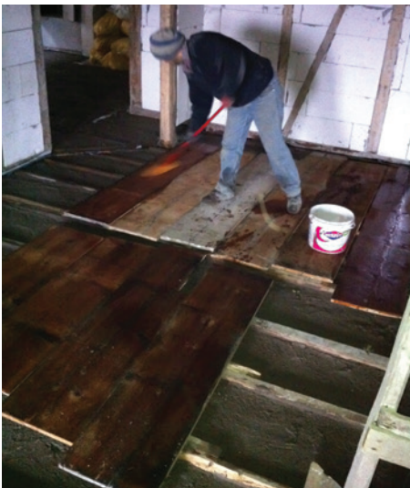
Resim 10. Yapıdan kurtarılabilen özgün döşeme elemanlarının empenye edilmesi (Safranbolu konaklarında çift döşeme bulunmaktadır. Bu döşemelerin arasına ortalama 8cm kadar toprak basılmaktadır (bulgurlama). Hazırlanmakta olan döşeme elemanlarının altında toprak dolgu gözükmemektedir.)
