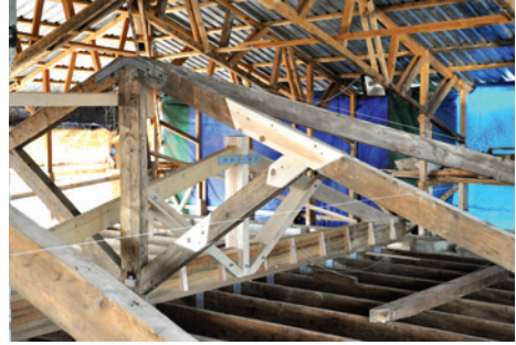
Resim 3. Yapı öğelerinin güçlendirme ve konservasyon uygulamaları
