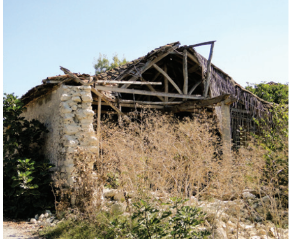
Resim 4. Çatalca'nın Baba Nakkaş Köyü'nde terk edilmiş bir kırsal yapı
