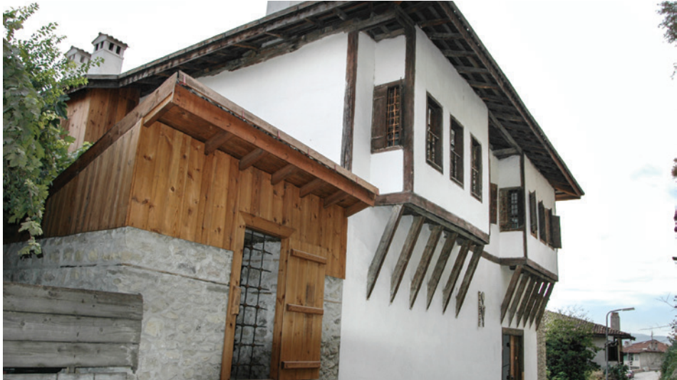
Resim 20. Kuzeybatıdan görünüm (Ön tarafta yeniden yapılan ahır gözükmektedir. Yalnızca moloz taş duvarlarının bir kısmı kalan samanlığın restitüsüyonu, aynı sokakta bulunan diğer samanlıkların tipolojisine göre yapılmıştır. Demir kafes, güvenlik nedeniyle kullanılmıştır.)
