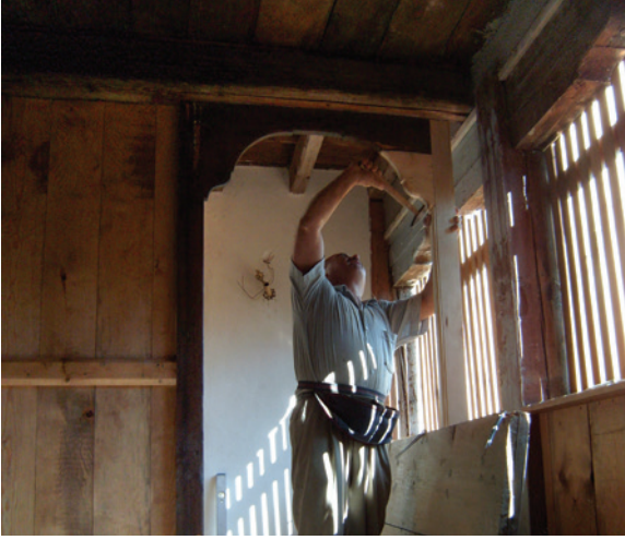
Resim 15. Bir tamamlama örneği (Kapı ve kemerli kasası, özgün yerleri konağın ilk sahiplerine danışılarak tespit edildikten sonra yerine yerleştirilmiştir.)
