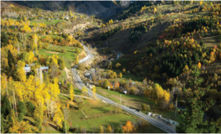
Resim 21. Papart Deresi üzerinde yapılan HES inşaat sahası
