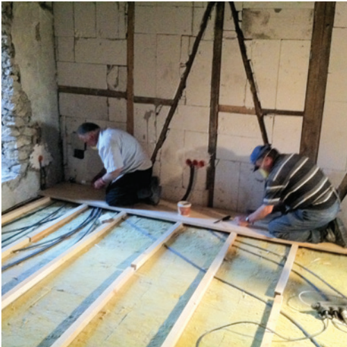
Resim 12. Çok amaçlı salonun üzerine gelen alanlarda ses yalıtımı amacıyla taş yünü üzerinde yüzer döşeme yapımı (Çeşitli kaynaklarda yüzer döşeme ile ilgili bilgi bulunmakla birlikte en önemli özelliği, hiçbir ahşap parçanın birbiriyle doğrudan temasta olmamasıdır.)
