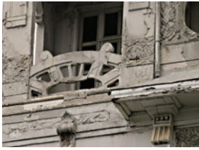
Resim 5. Cephede yer alan çimento esaslı ön yapım elemanlar
