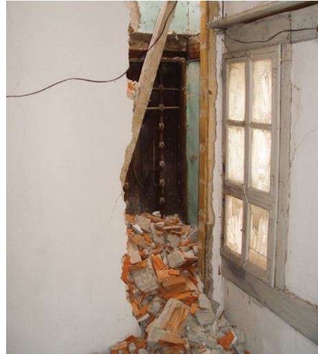
Resim 5. Duvarla kapatılan pencereler açılmıştır.
