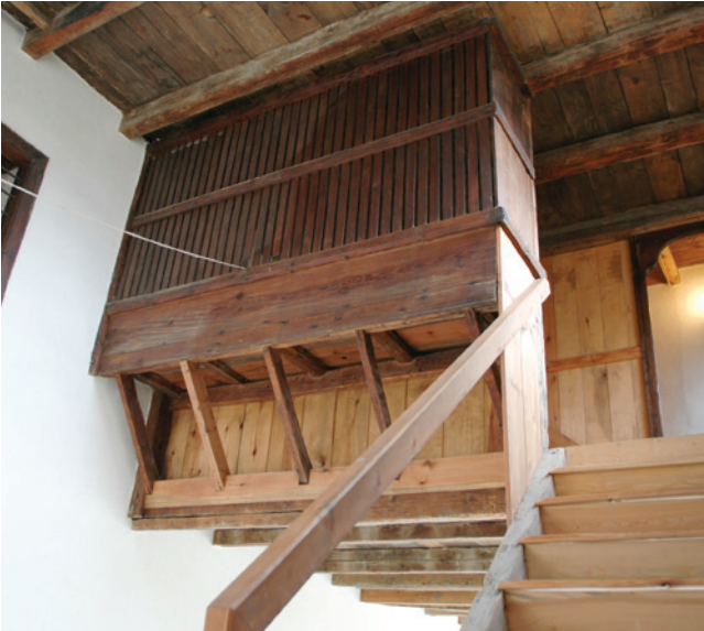
Resim 23. Girişte üst katta bulunan cumba (Mahremiyeti ifade eden cumbadan gelen ip, kapı kilidini açmaktadır. Sağda görülen ahşap duvar, geçmişte ısıtılmayan mekânın ısıtılabilmesi için özel olarak yalıtılmıştır. Ahşap duvarın üzerinde bulunan kafeslerin önüne yerleştirilen camlar, havalar ısındığında kaldırılarak doğal havalanma sağlanmaktadır.)
