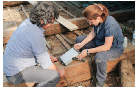
Resim 23. Kirişler üzerinde ultra ses dalgası ile ölçüm yapılması
