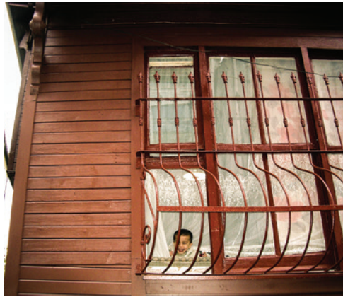
Resim 15. Zeyrek Fazilet Sokak 14 no'lu evin onarım sonrası görünümü (14 Kasım 2004)
