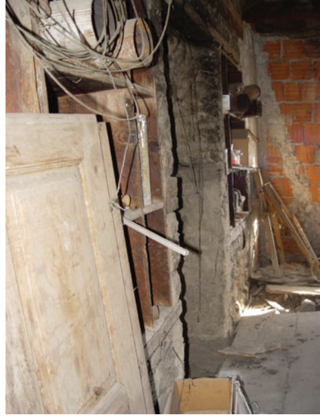
Resim 4. İç görünüş (Dolap kapakları ve davlumbaz sökülmüş, ocak boya kazanı kaynatılabilecek ölçülere getirilmiştir. Kârgir eklemeler ve tamirat yapılmıştır.)
