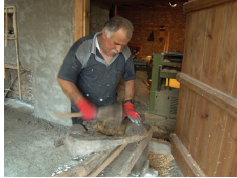
Resim 19. Perdah harcı için kırığın kıyılması (Perdah harcı, İBB KUDEB Restorasyon ve Konservasyon Laboratuvarı'nda analiz edilen özgün perdah örneğine göre hazırlanmaktadır.)
