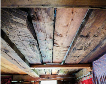
Resim 14. Dandraba mekânının tavanında görülen balta izleri
