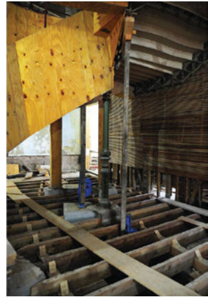
Resim 9. Ahşap konstrüksiyonun onarımı (Sistemin krikolarla kaldırılması)
